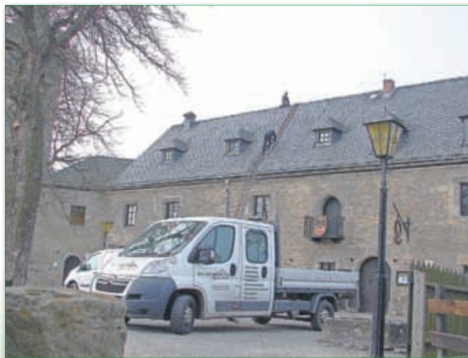
Die Dachdecker bei den Reparaturen auf der Hofseite
