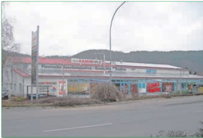
Rudolstädter Straße 35, Neubau von 1990/91
