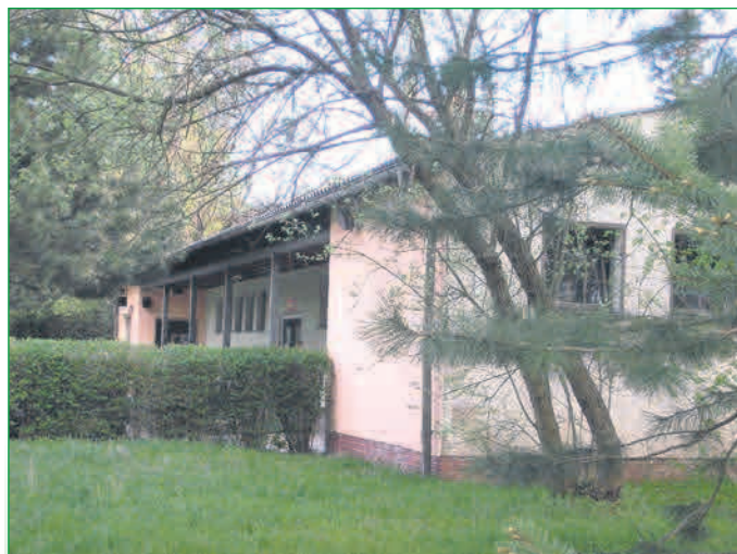
Umkleidegebäude Badseite – jetzt gastronomische Einrichtung
