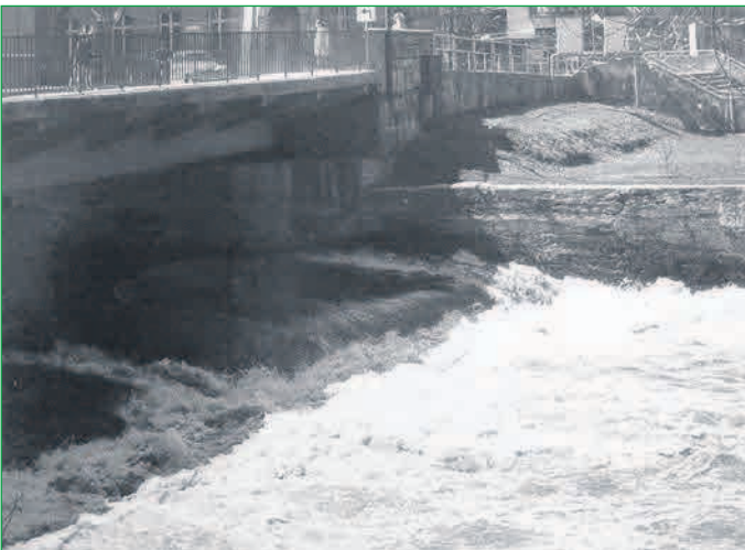
Das ehemalige Wehr unterhalb der Stadtbrücke
