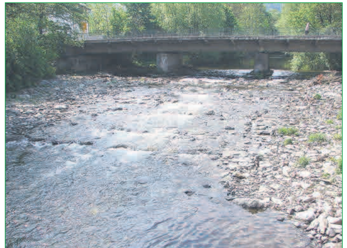
Eine letzte Aufnahme von der Brücke zeigt das zurückgebaute Wehr.
