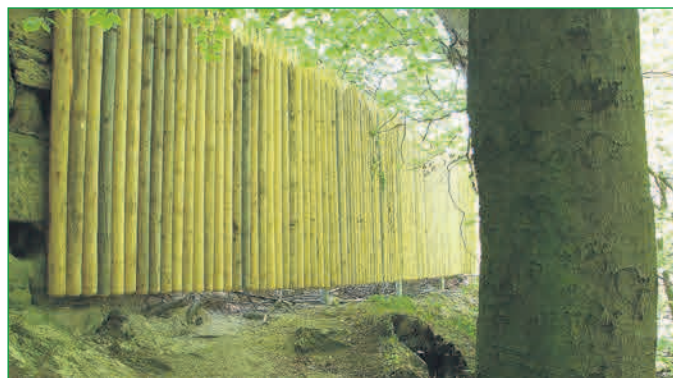
Der fertiggestellte Palisadenzaun
