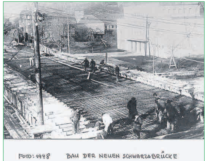
Bevor der Beton eingebracht werden kann, muss die Bewehrung verlegt werden.
