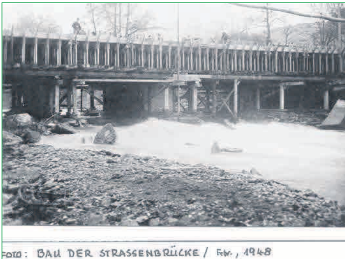
Die gesamte Brücke ist eingeschalt.
