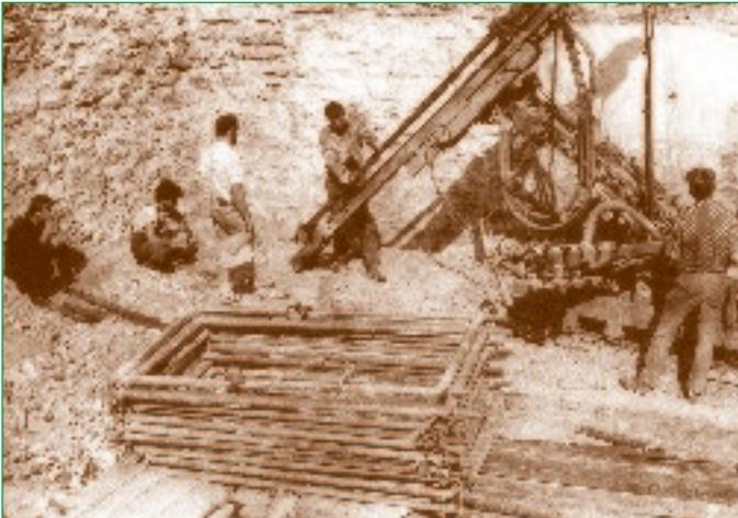
*Das schwere Bohrgerät*
