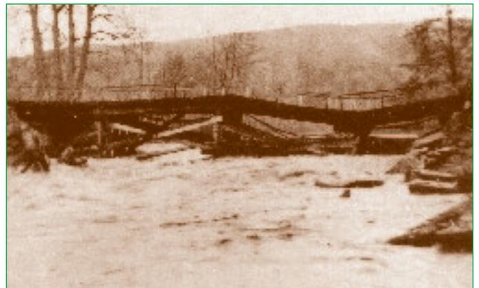
Nach der Stabilisierung der Notbrücke kam Sie 1947 bei einem Hochwasser der Schwarza zum Einsturz. Foto: 1947, Dez.
