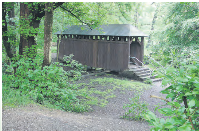
Die Hausbrücke am neuen Standort über die Lache am Chrysopraswehr
