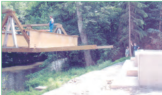
Die letzten Meter, dann steht die Behelfsbrücke
