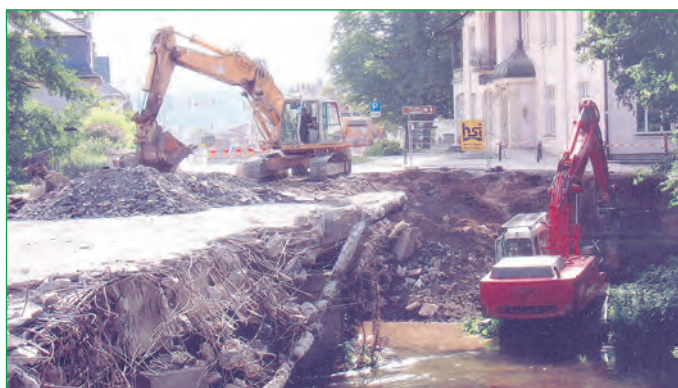
Der Abriss beginnt
