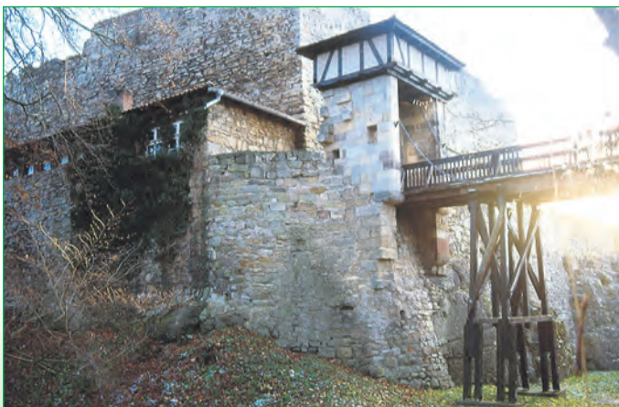
Das fertige Brückenhaus, links davon, die Werkstatt
