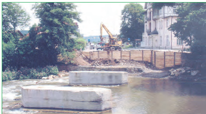
Pfeiler und Widerlagerreste sind für die neue Brücke verwendbar und werden ergänzt.
