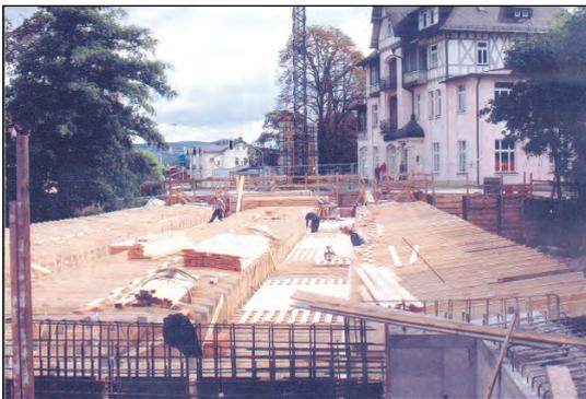
Die Betonschalung wird aus vorgefertigten Teilen montiert
