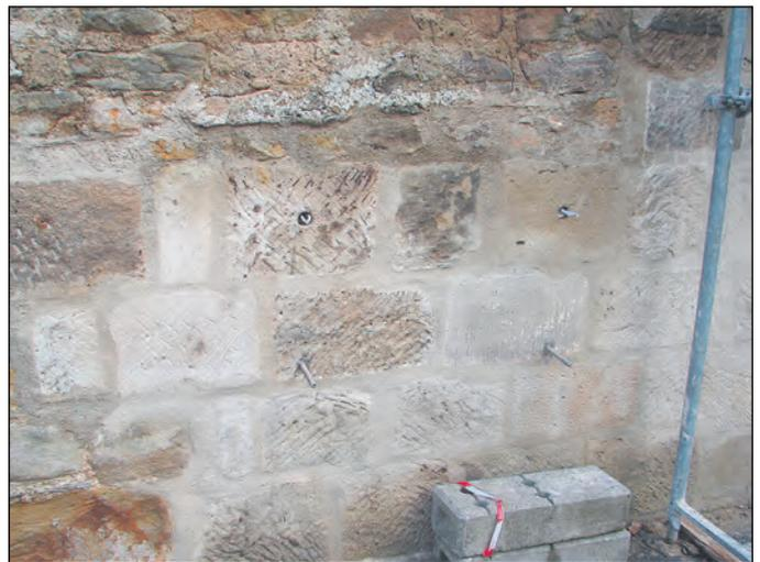
Diese Spezialanker sichern den Mauerfuß links vom Eingang
