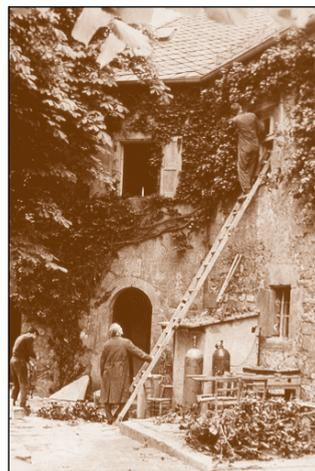
*Eine Ansicht der Hofseite des Palas. Sie war ehemals dicht mit Efeu bewachsen. Das musste entfernt werden, um Schäden am Mauerwerk und an der Dachdeckung vorzubeugen.*
