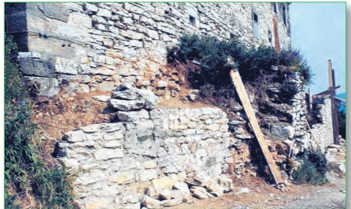
Zu den ersten Maßnahmen des 1978 im Rahmen des Kommunalen Zweckverbandes gegründeten Baustabes Greifenstein gehörten die Sicherung der Südostecke des Palas (siehe G.-B. März 2007 - Werner Riedel, Sanierungs- und Werterhaltungsarbeiten zu Zeiten der DDR) und die schrittweise Erneuerung der dortigen Zwingermauer. In Absprache mit dem Institut für Denkmalpflege Erfurt entstand vor dem Hauptbau eine Terrasse für die Gaststätte der Burg.
