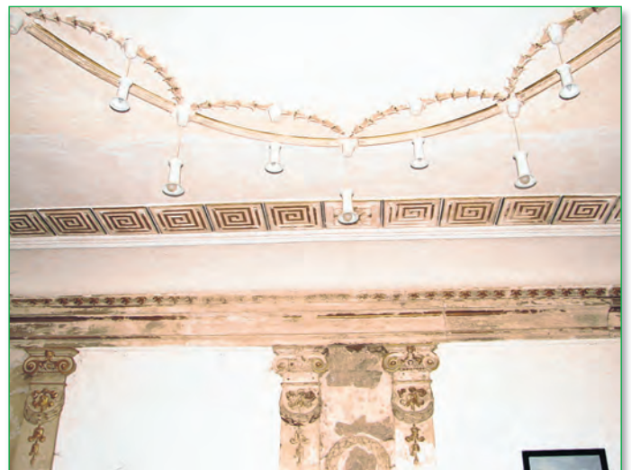
Stuckdecke mit Teilen des Lampenovals heute
