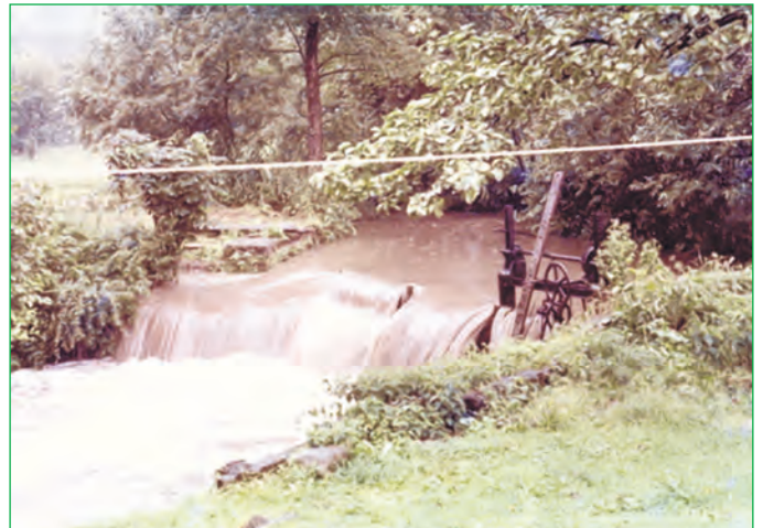
Wehr - nach dem Hochwasser 1981 der Rinnebegradigung zum Opfer gefallen
