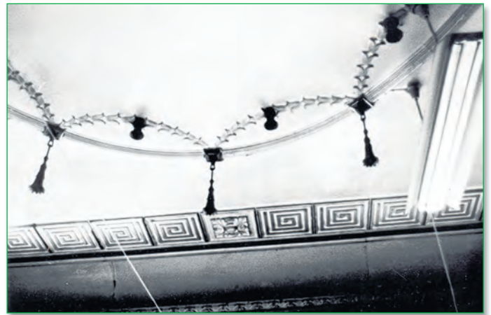
Eine frühere Aufnahme mit Originalbeleuchtung
