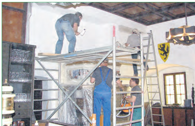
Die letzten Arbeiten am neuen Ofen und der Wand mit dem Schornstein
