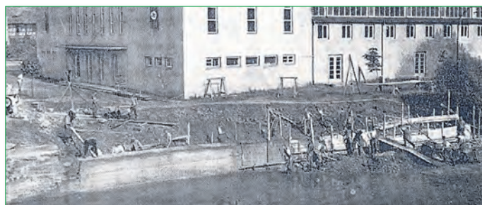
Mauerbau des RAD
