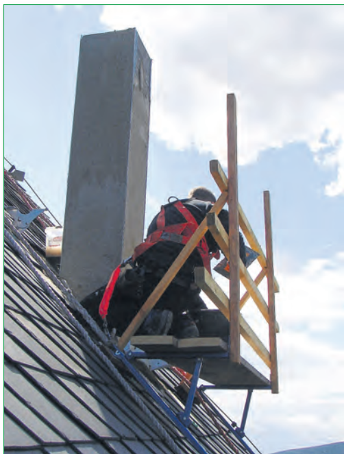
Die letzten Arbeiten am Schornstein
