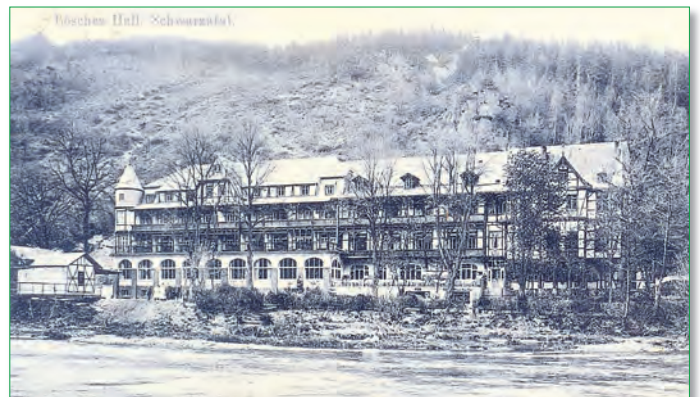
zweiter Erweiterungsbau auf der linken Seite
