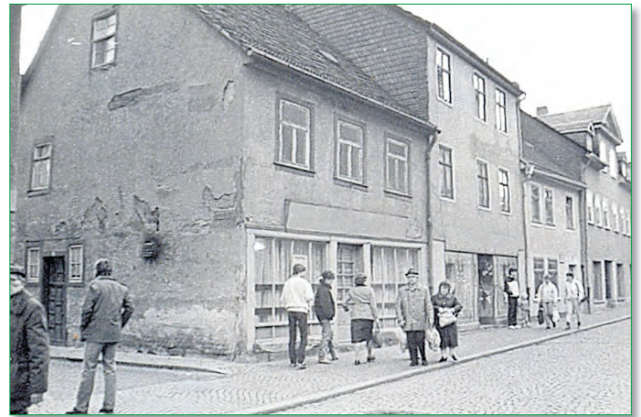
vor dem Abriss
