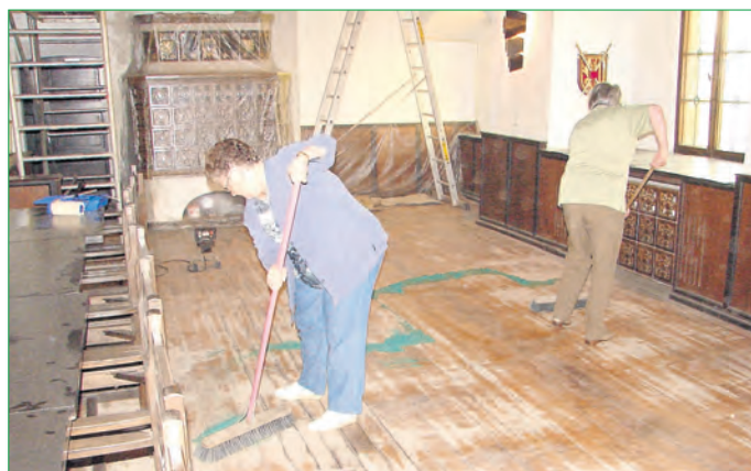
Grobreinigen des Fußbodens
