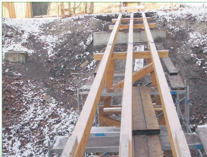
Der Schnee brachte eine kurze Unterbrechung nachdem die Längsbalken verlegt waren
