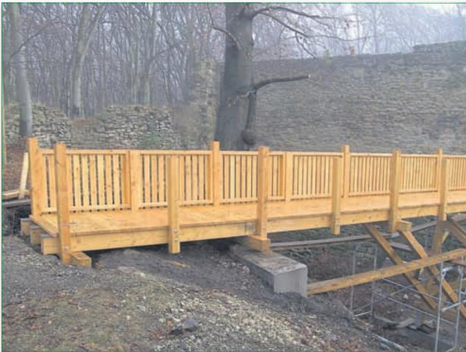
Der Brückenbelag ist verlegt und vorgefertigte Geländerfelder werden eingesetzt
