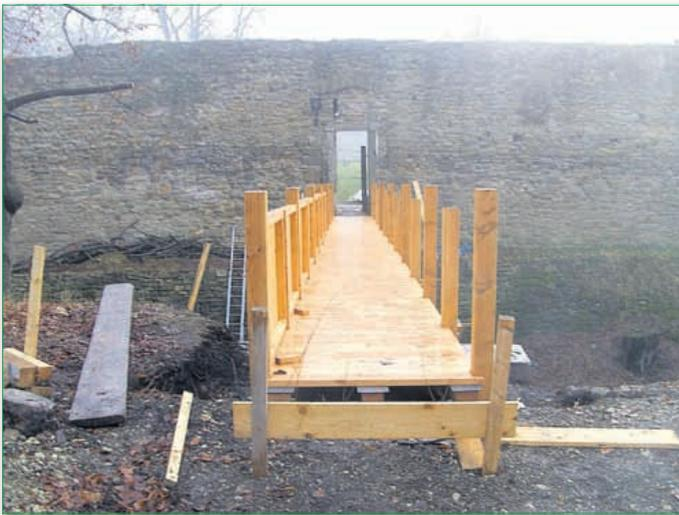
Die Geländerstützen werden montiert
