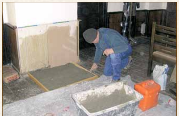
Ofenbaumeister Dieter Vollrath setzt das Ofen-Fundament
