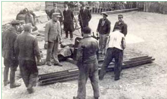
Der Aufzug ist bereit
