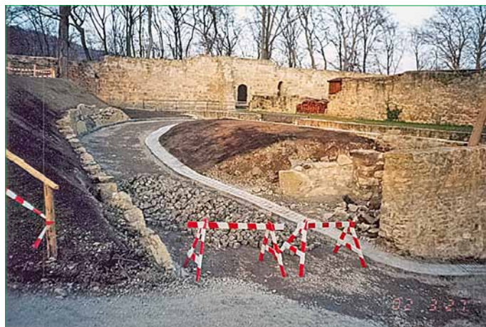
Die neue Auffahrt
