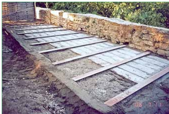
Abdeckung des Treppenabgangs
