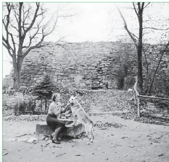
Fläche über den Tonnengewölben – rechts die Bohlenabdeckung, gleichzeitig Zugang zur Tanzfläche, links unter dem Baum der Zugang zum südl. Gewölbe
