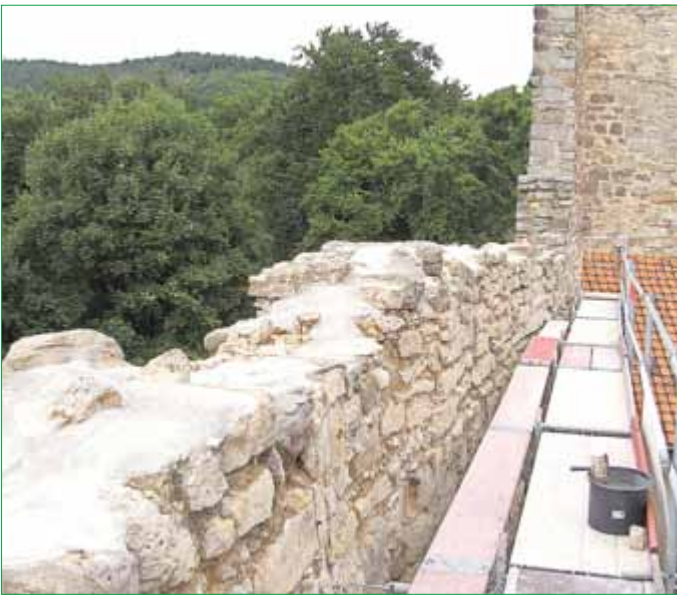
Die gesicherte Mauerkrone
