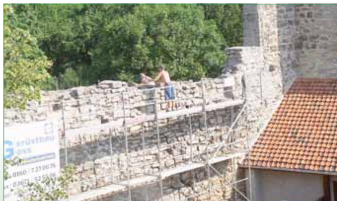
Die eingerüstete Westmauer
