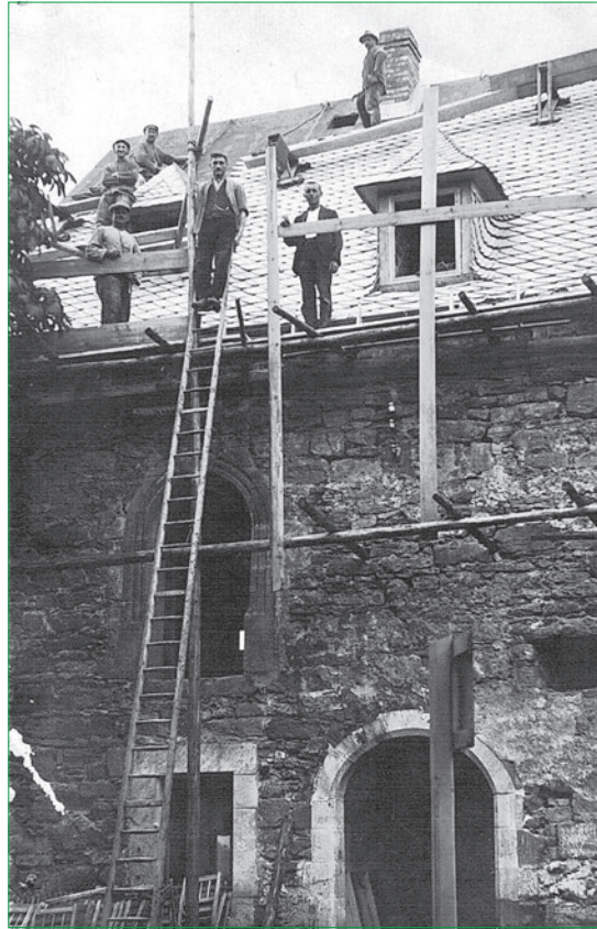
Palas des Greifensteins. Nach dem Ausbau der westlichen Gebäudehälfte 1925 bis 1927 brachte Eduard Scheller (rechts neben der Leiter) die Dachrinne an
