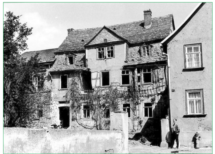
April 1988 - Wohnhaus vor dem Abbruch
