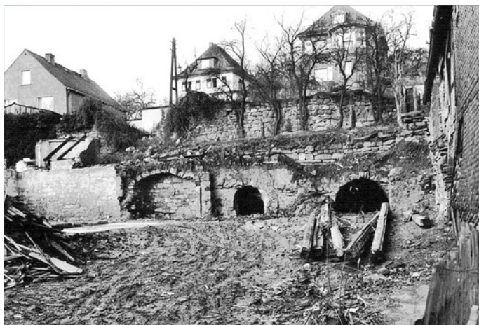
November 1988 - freigelegte Gangkeller
