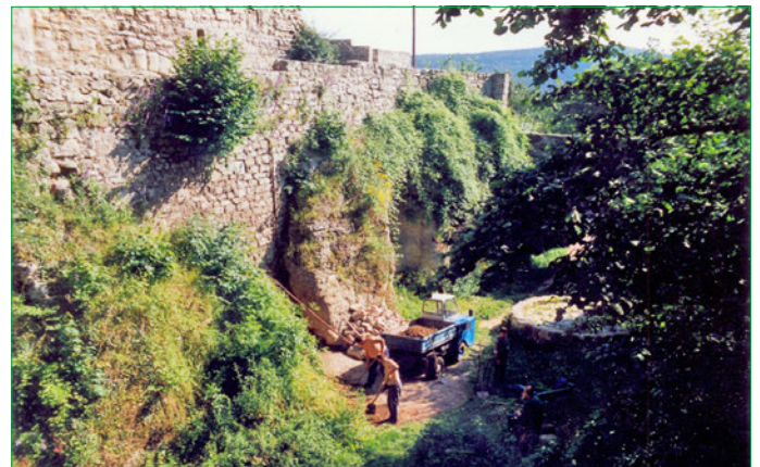
1990 - Planierung des Brunnengrabens
