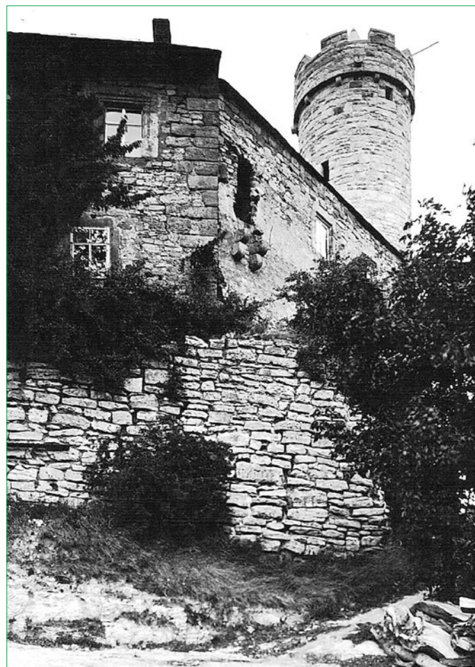
Loch in der Fassade
