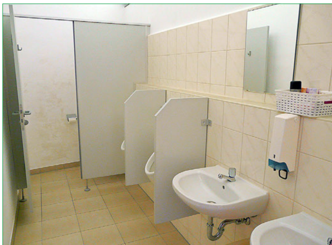
Neue Toiletten für Herren ...
