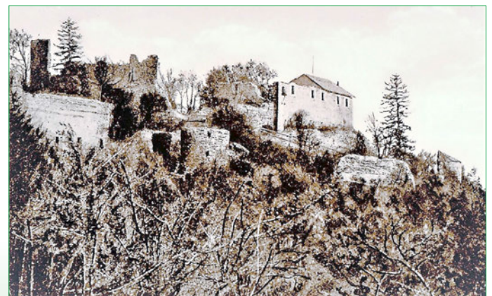
Palas (rechts) noch ohne Erdgeschossfenster
