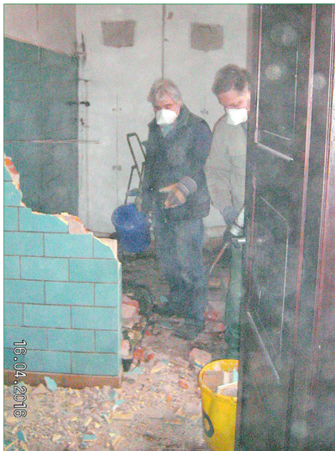
Demontage der alten Toiletten
