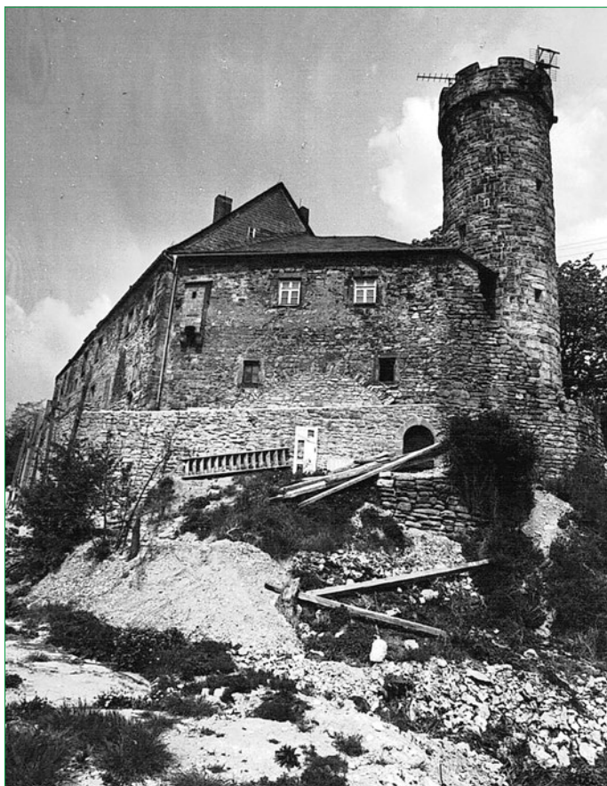
Die Umbauspuren von 1978/1980
