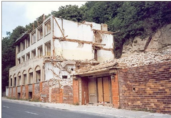
Abriss von Lösches Hall 1999
