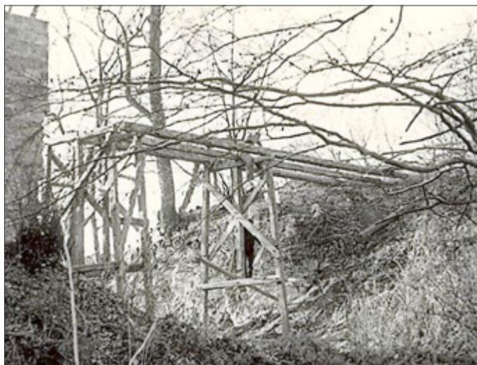
Brückenbau über den Brunnengraben
