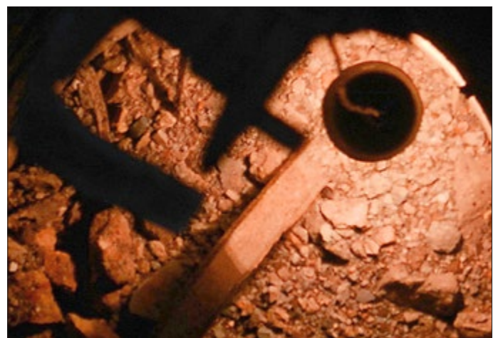
Brunnensohle in 40 m Tiefe
