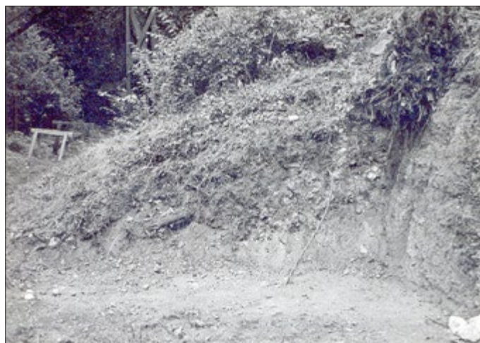
Freilegung der Brunnengrabensohle
