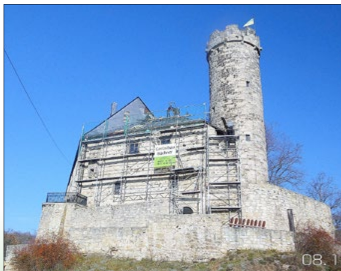
Dachreparatur am Zwischenbau
