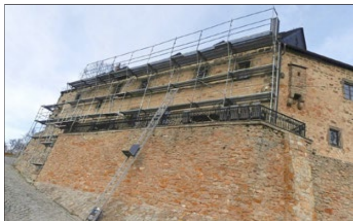
Dachreparatur am Palas
