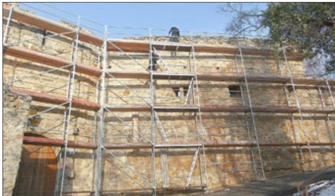
Gerüst an der Südmauer-Feldseite
