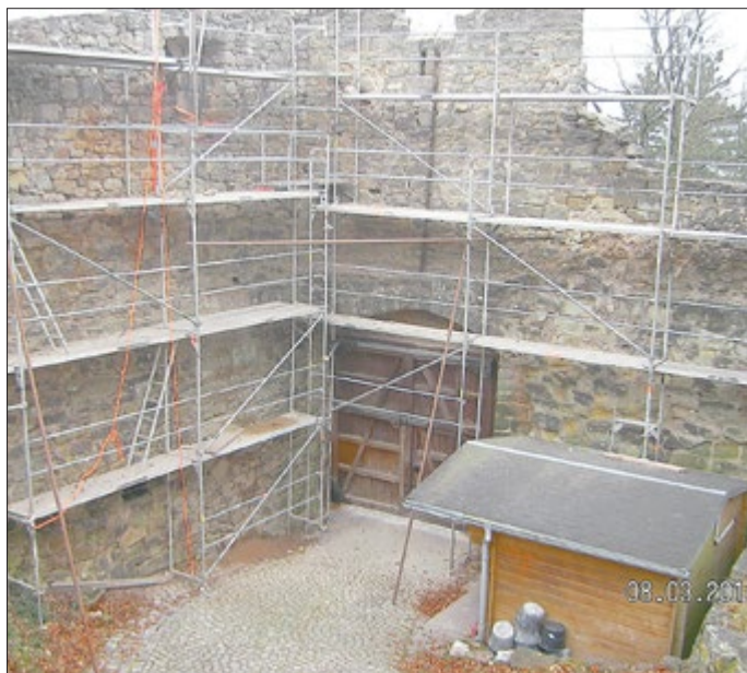
Reparatur der Mauer am Haupttor
