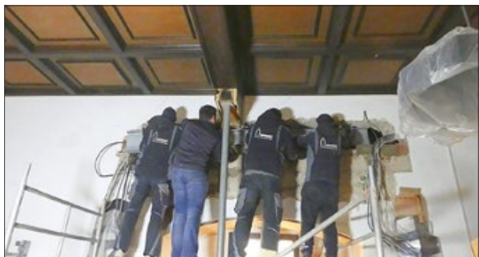
Einbau der Träger
