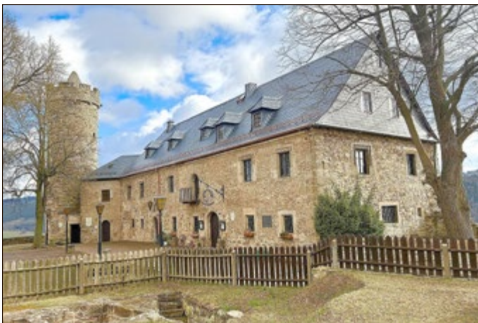
Westgiebel des Palas - das Foto von Andreas Munsche entstand kurz nach Abschluss der Dachdeckerarbeiten auf der Hofseite des Gebäudes
