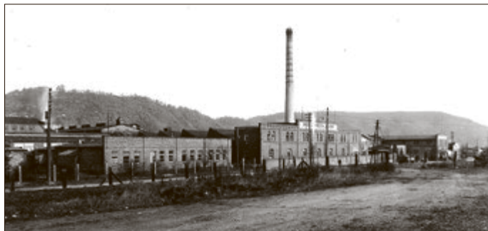
Gebäude der Industrieschlauchproduktion, im Hintergrund der Schornstein des alten Kraftwerks am Haupttor, Rudolstädter Straße
