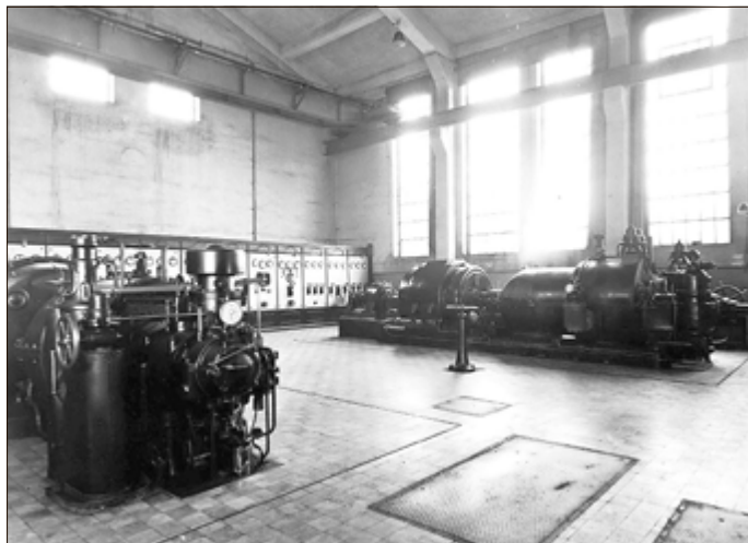
Die Kraftwerkszentrale (Maschinenhaus)
