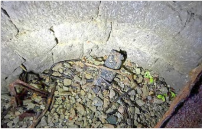
derzeitige Brunnensohle in 40 m Tiefe
